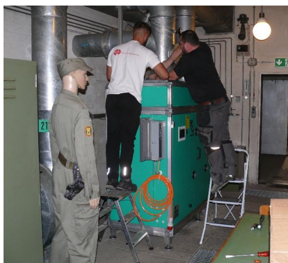
Anschluss an die bestehenden Zu- bzw. Abluftrohre überwacht vom Festungswächter
