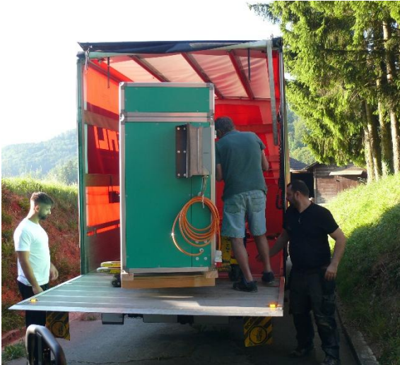
Anlieferung und Einbau des neuen Entfeuchters im Maschinenraum
