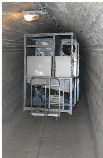
Transport mit einem Habegger den Zugangsstollen hinauf bei sehr engen Platzverhältnissen
