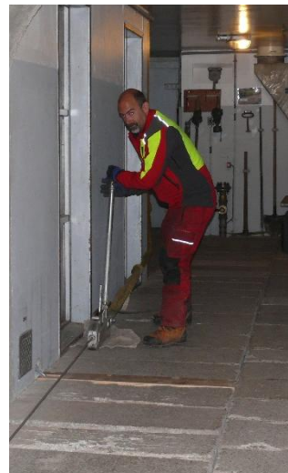
Transport mit einem Habegger den Zugangsstollen hinauf bei sehr engen Platzverhältnissen
