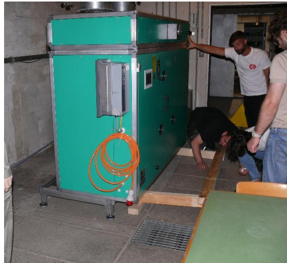
Anlieferung und Einbau des neuen Entfeuchters im Maschinenraum
