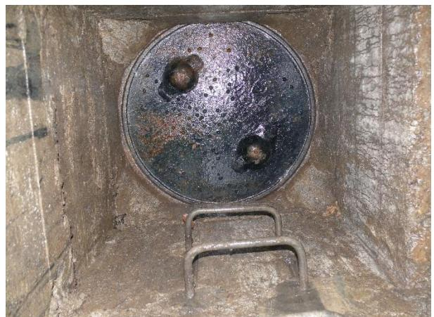
Zugemauerter Teil des Ausstiegs- schachtes und der wieder überdeckte Dolendeckel von unten.
