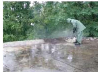
Zuerst werden sämtliche Risse mit Bitumen-Kaltklebemasse ausgestrichen. Dann müssen diese Stellen mit Bitumen-Spachtelmasse ausgespachtelt und zum Schluss wird der Betonwulst inklusiv angrenzendes Dach vollflächig mit Kaltklebemasse gestrichen und das mit zwei Anstrichen. All diese Arbeiten können erst im nächsten
