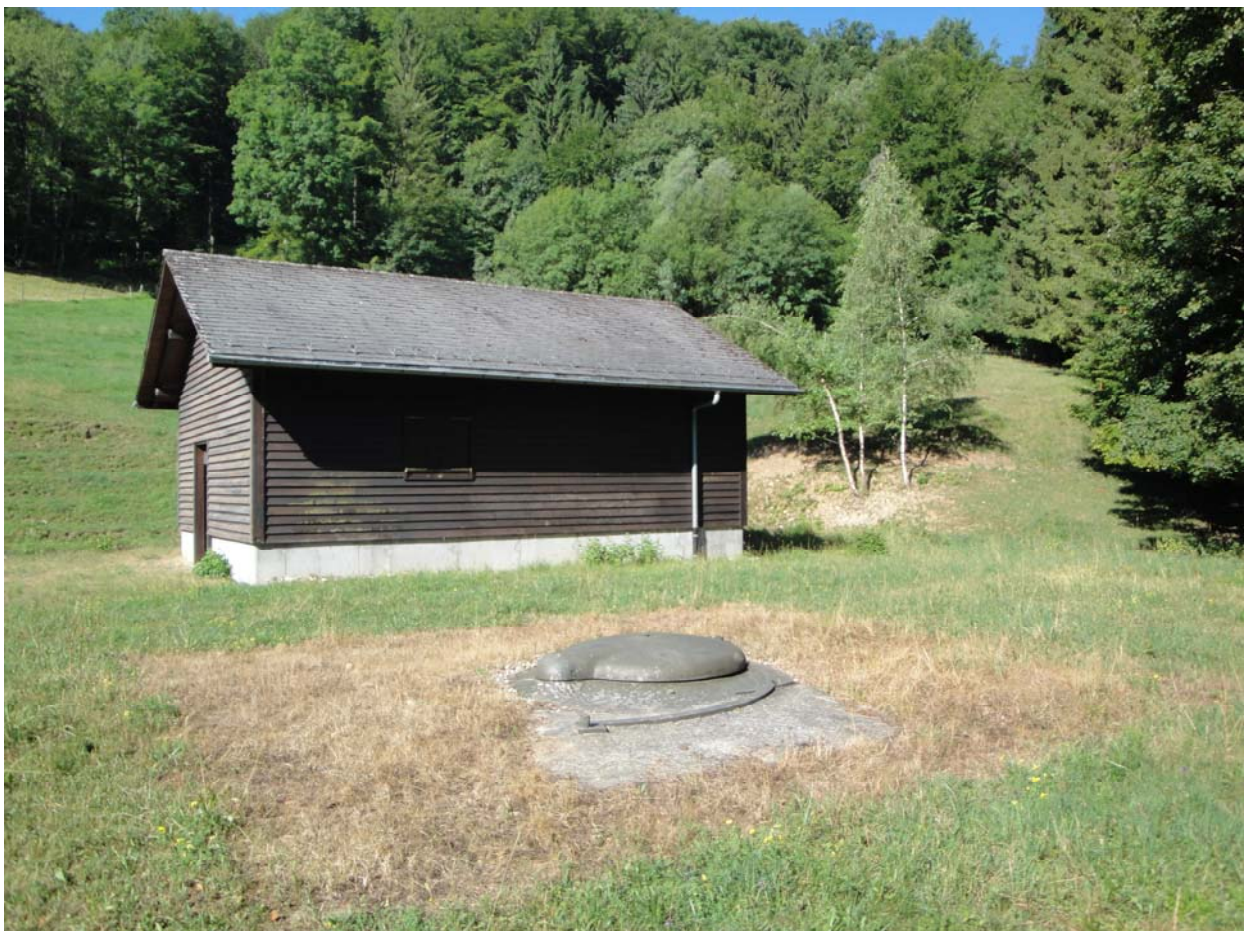
Festungsminenwerfer Typ „Hotel“ der frühen 80er Jahre. Tarnbau mit Einstieg, Deckel über der Waffe.
