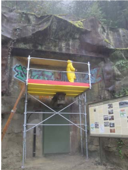
Tarnung Stand 1: Nach Reinigung und Sanierung der Betonschäden werden beide Tarnungen rekonstruiert: Die Tarnbemalung von 1938 und die Felstarnung von 1958.
