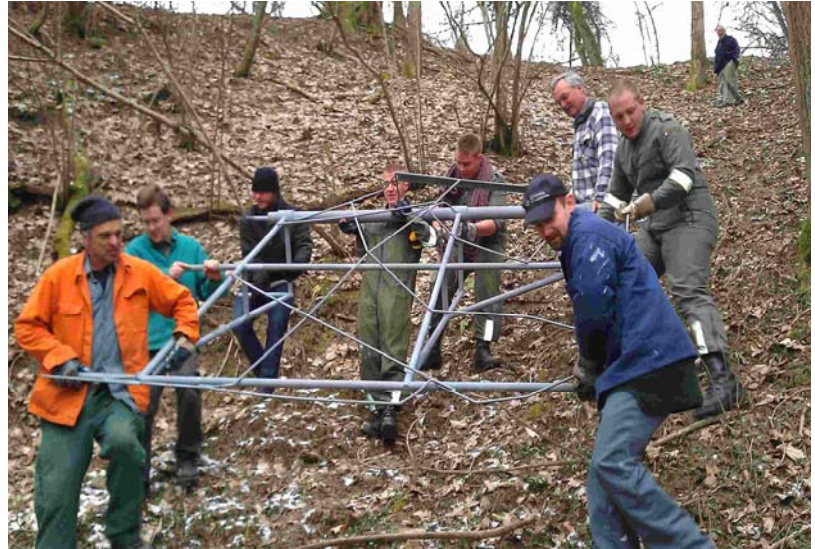
Tarnung Stand 1: Das herunterklappbare Tarntor vor der Scharte wurde neu nachgebaut, verzinkt und in zwei Hälften den steilen Hang der „Urfelen“ hinabgetragen. Das Bild zeigt die typische Zusammensetzung an den monatlichen Arbeitstagen „Werken in Werken“: Vom Rekruten bis zum Pensionierten.
